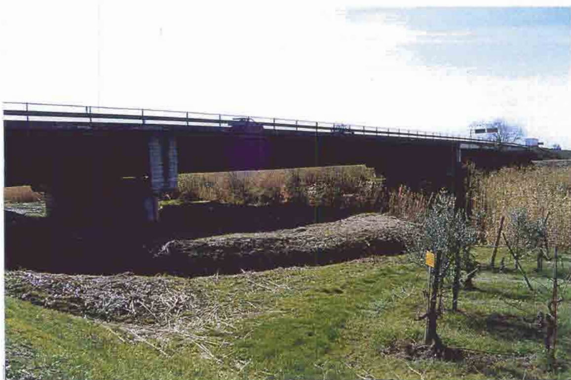
Foto 6 - Viadotto della S.G.C. FI-PI-LI visto da valle
