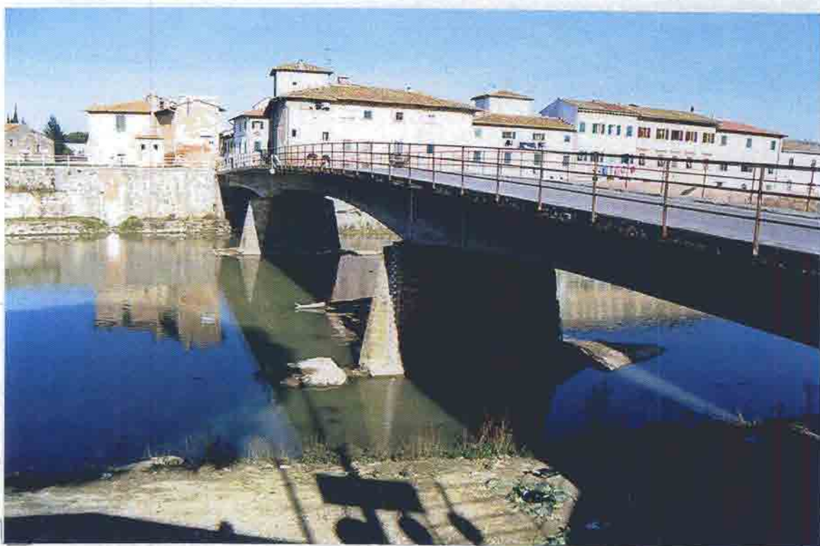
Foto 12 - Ponte di foto 11 visto da valle. Sono evidenti i due piloni nell'alveo del F. Elsa
