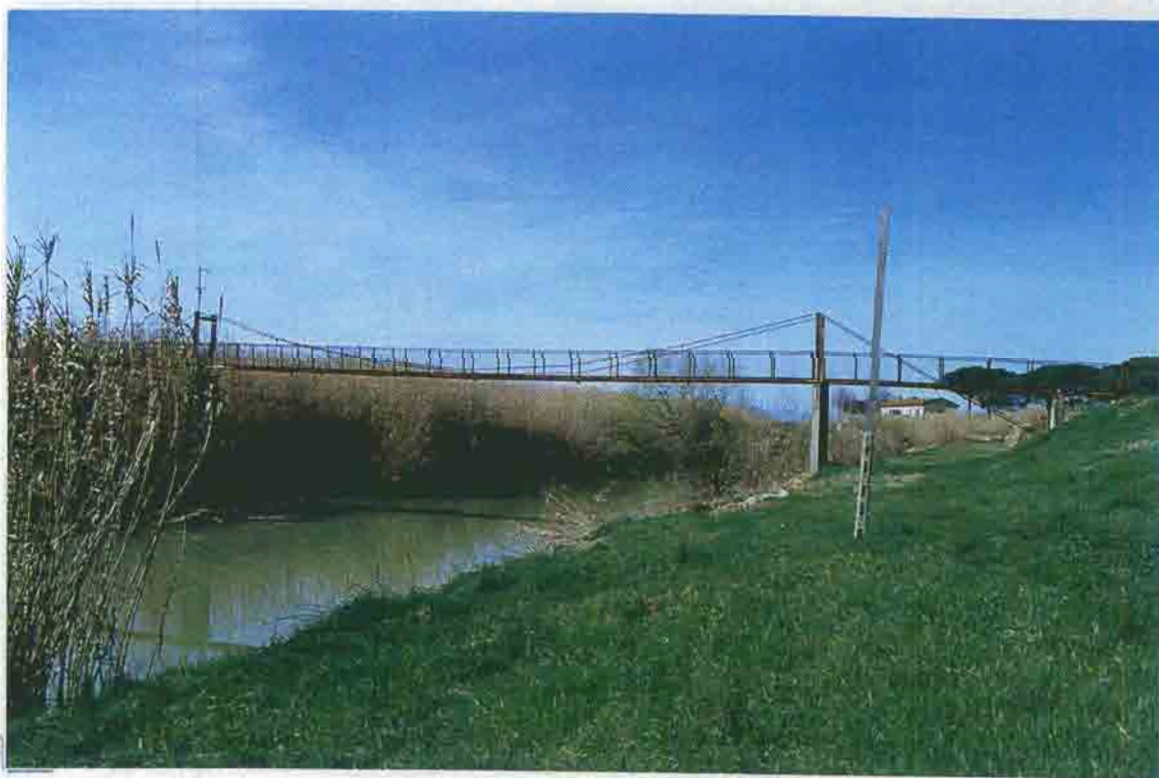
Foto 18 - Passerella pedonale in località S. Andrea
