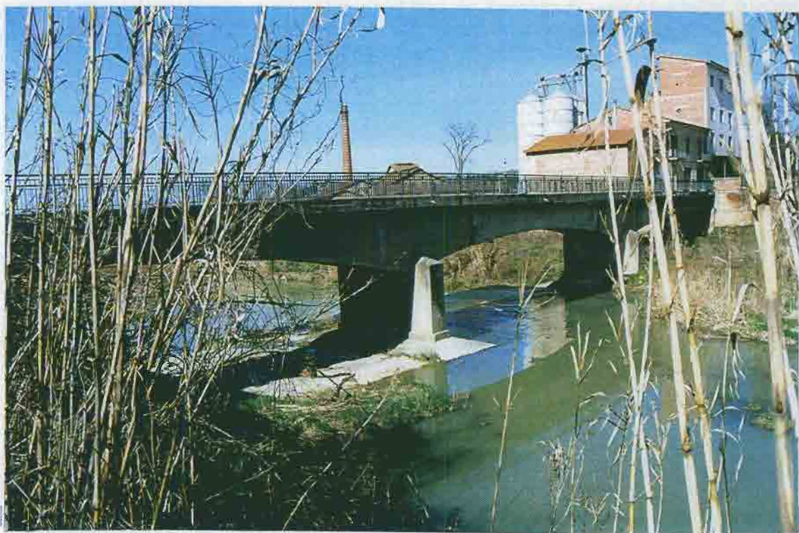
Foto 19 - Ponte a monte di Fontanella. Sono visibili due piloni nell'alveo
