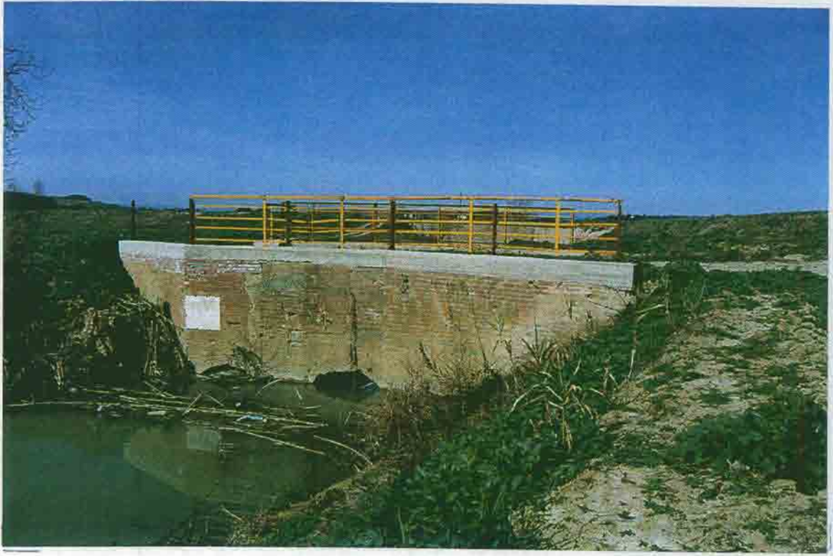
Foto 15 - Opera idraulica all'imbocco del Rio Molin Nuovo
