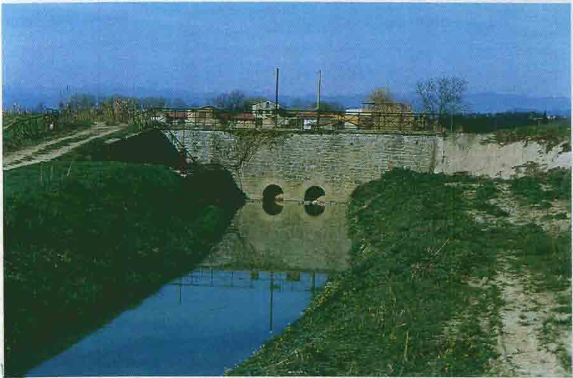
Foto 16 - Opera idraulica all'imbocco del Rio Molin Nuovo
