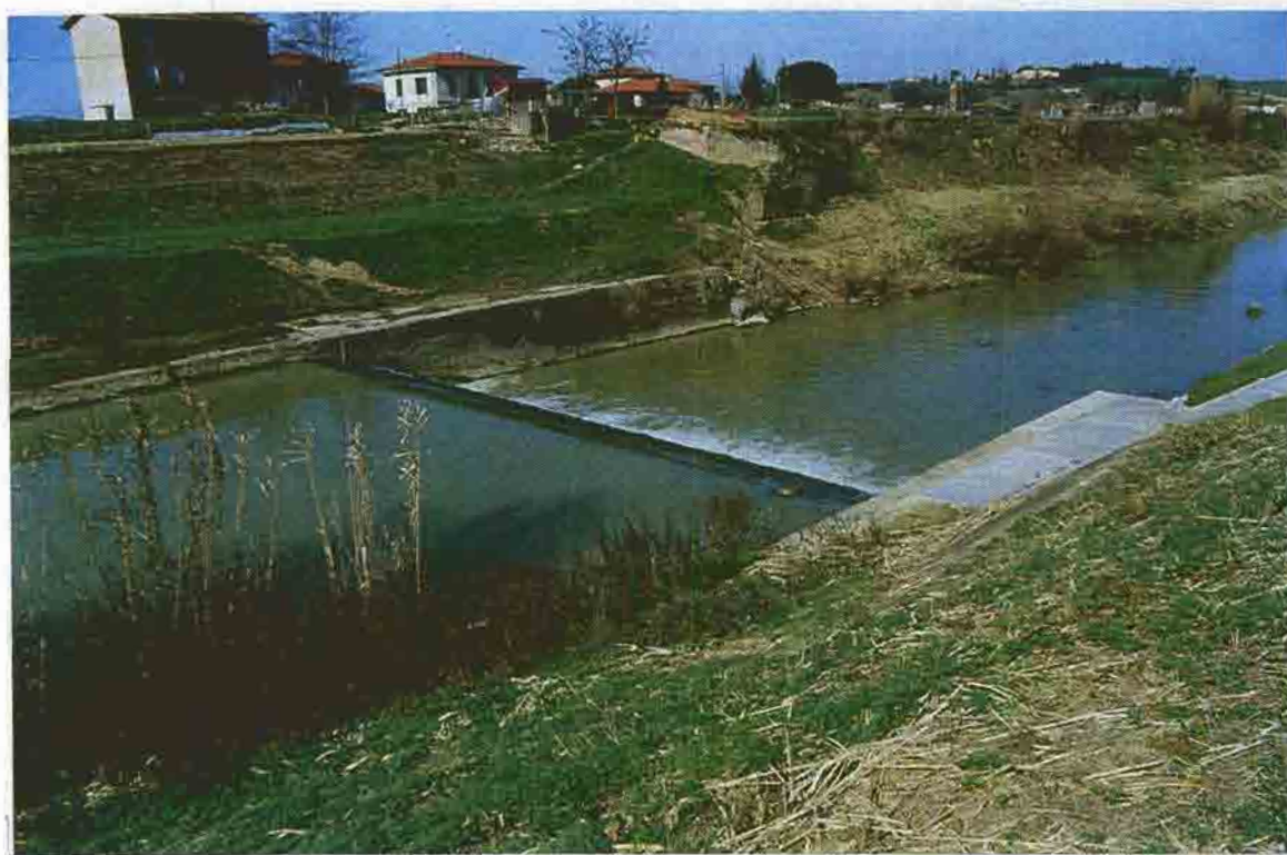
Foto 2 - Briglia in prossimità dello sbocco dell'Elsa nell'Arno
