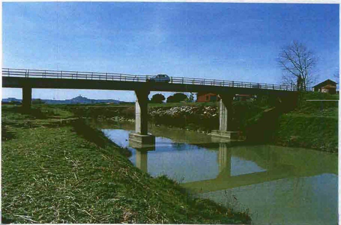
Foto 4 - Ponte in località Isola. Si notano due piloni nell'alveo dell'Elsa
